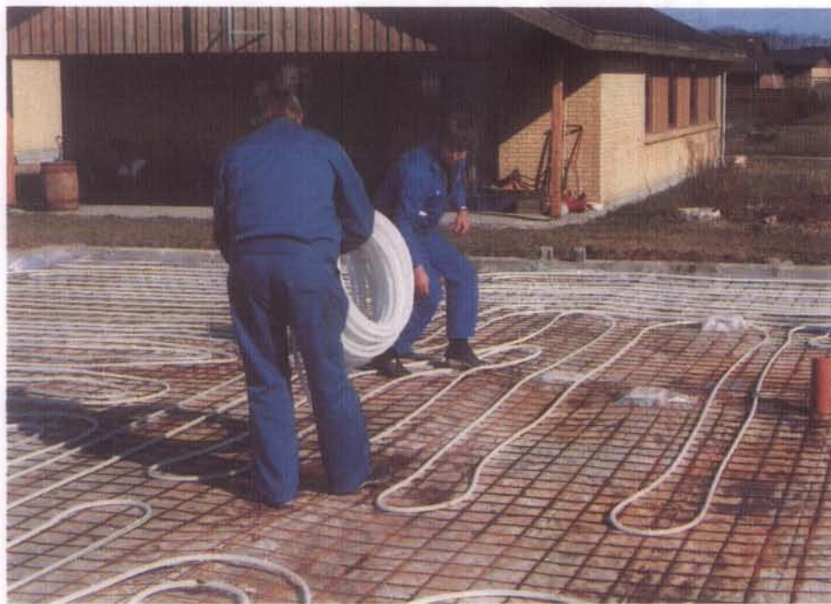
Wirsbos golvvärmsystem spar 15 procent energi jämfört med en vanlig radiatorutrustning. Lämpar sig lika väl för installation i bostadshus, som i offentliga lokaler, idrottshallar, butiker mm.
