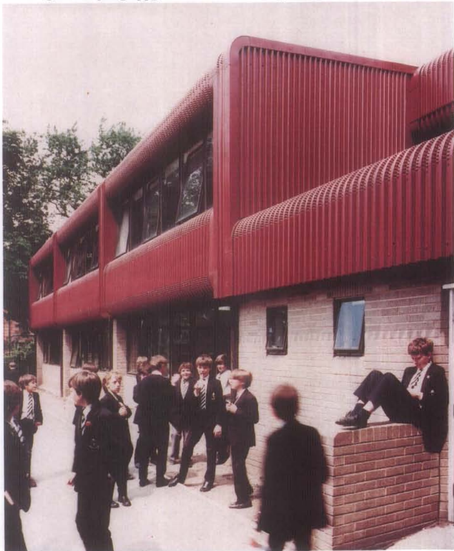
Gränges Aluminium har framgångar på den engelska marknaden. Här Korrugal byggplåt för tak och fasader på en skola i Liverpool.
