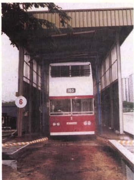
Busstättanläggningar har installerats bl a i Singapore.
