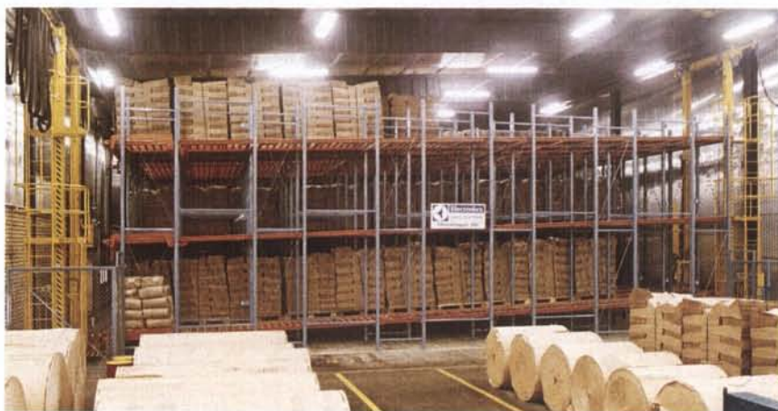
A Interiör av färdigvarulagret med rullfack och automatstaplare i säckfabriken enl. principskiss, sid. 18.
