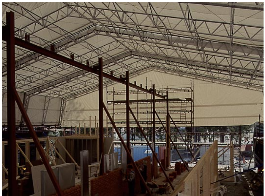
Avec le système "Torra Byggen" de Jonsered, les travaux de chantier se font à l'abri, ce qui contribue notamment à empêcher les problèmes futurs de moisissures.
