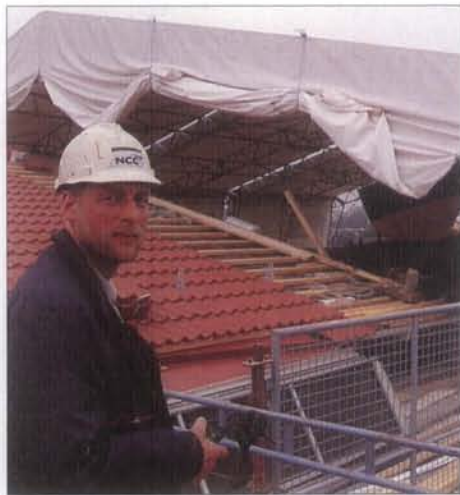
Jonsereds nya koncept "Torra byggen" håller byggmaterialet torrt från leverans till färdigt bygge och bidrar till en förbättrad produk- tivitet och kvalitet i byggprocessen. Det viktigaste är täckningen av taket som sker med ett nytt väderskydd som löper på räls.
