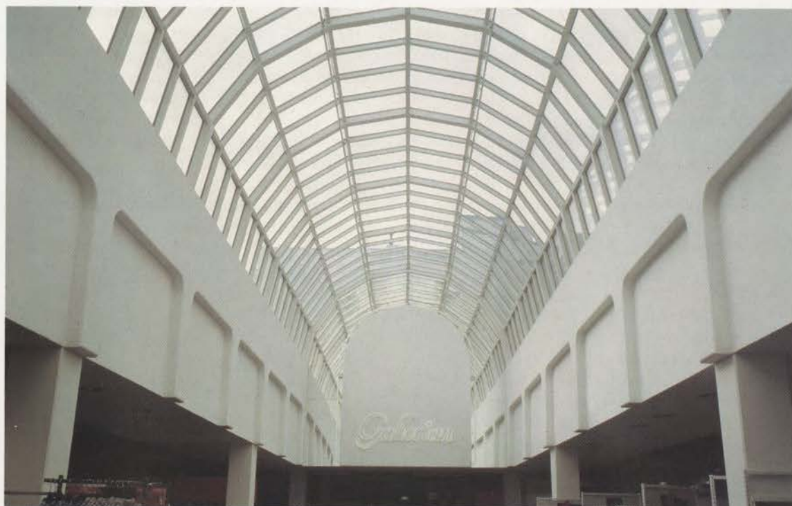
Byggindustrin är Gränges Aluminiums största kund. Här har SAPAs aluminiumprofiler använts för överglasning av ett nybyggt köpcentrum i Malmö.
